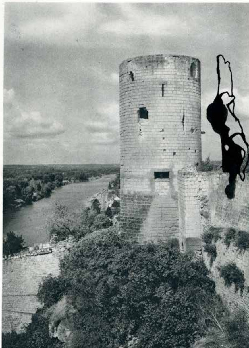
CHÂTEAU DE CHINON. LA TOUR DU MOULIN ET LA VIENNE.
